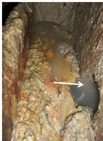
Figur 4. Utløpskasse i dårlig vedlikeholdt utskiller. Fett vil her føres urensset ut på avløpet (pil).
