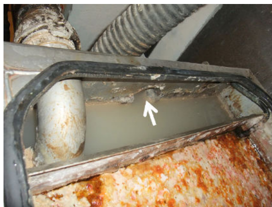
Figur 5. Fettutskiller som fungerer etter hensikten. Fettet holdes tilbake i utskillerdelen, og utløpskassen er ren. Pilen viser utløp fra utskilleren.
