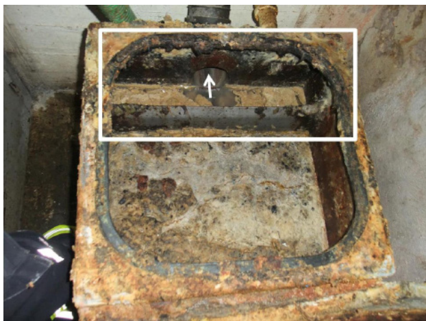
Figur 3. Bilde av en dårlig vedlikeholdt fettutskiller. Utskilleren er ikke tømt, og det er ikke lokk på utløpskassen. Fettet kan derfor renne rett over skilleveggen og ut på avløpet (pilen).
