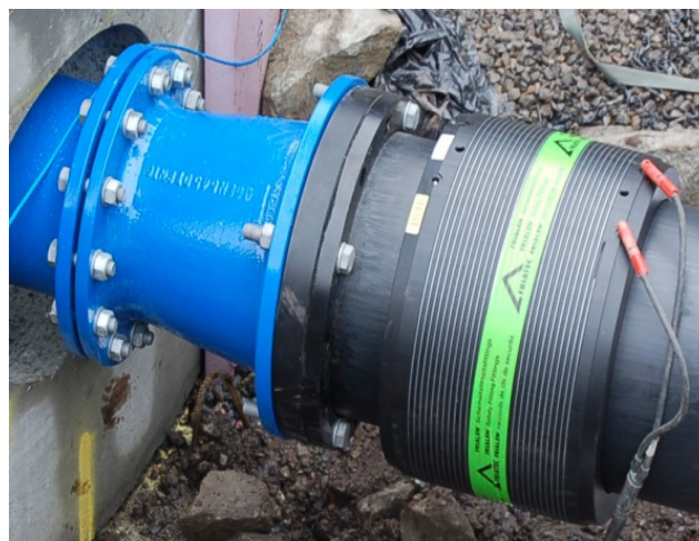
Bilde 5. Sammenkopling av PE-rør/stj.-flens, ved bruk av elektromuffe og PE-krage/løsfrens.
