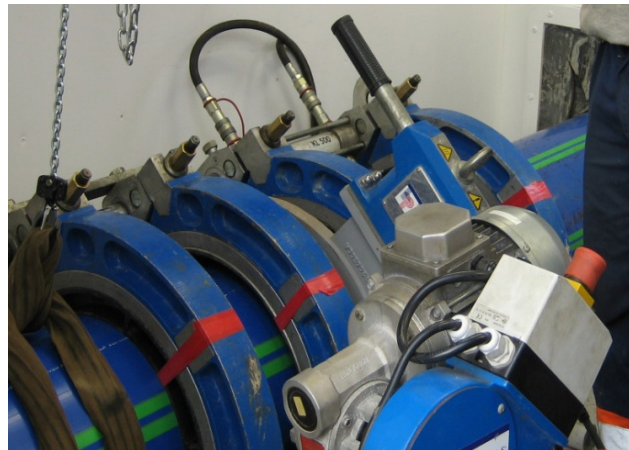
Bilde 3 og 4. Speilsveising i sveise-container.
