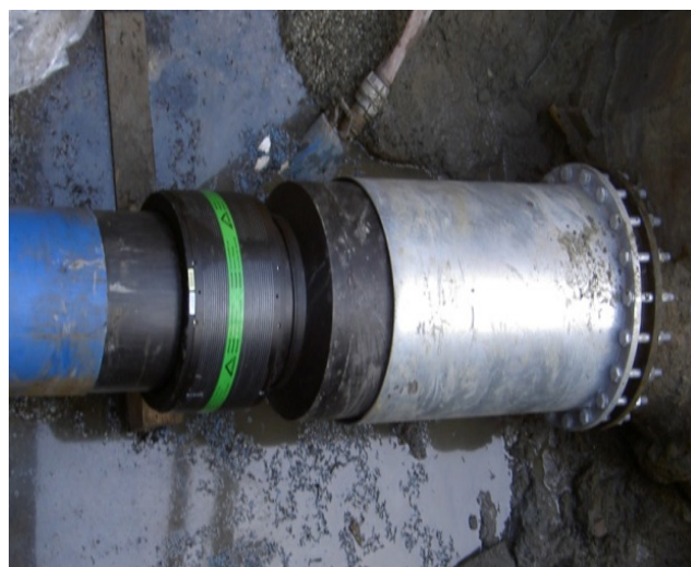
Bilde 8. Flensetilknytning til kum med varmforsinket styrerør.
