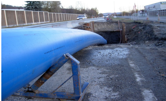
Bilde 6. PE-røret beskyttes mot ytre skader.
