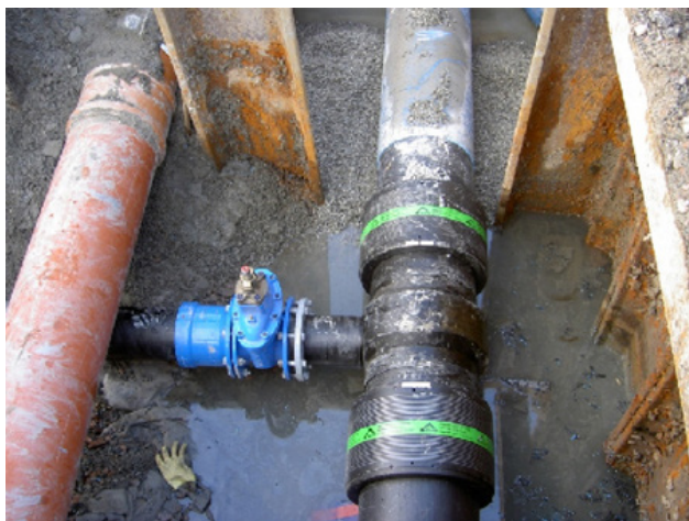
Bilde 7. Avgrening på helsveiset PE-rør, ved bruk av Trør og elektromuffer.
