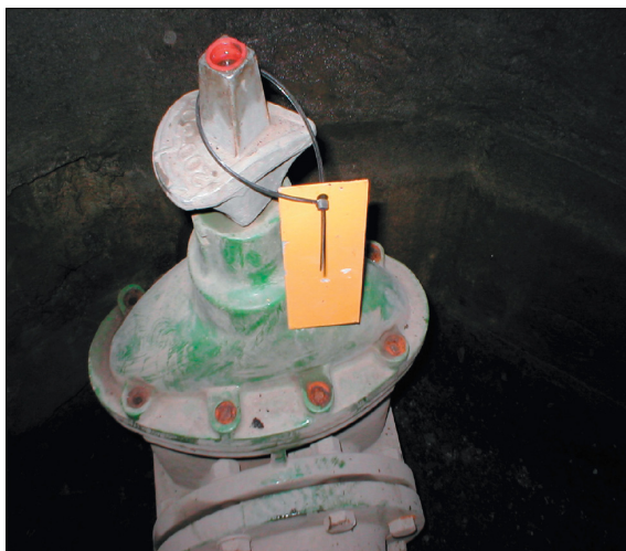
Figur 4: Merkeskilt ved ventilmanøvrering
