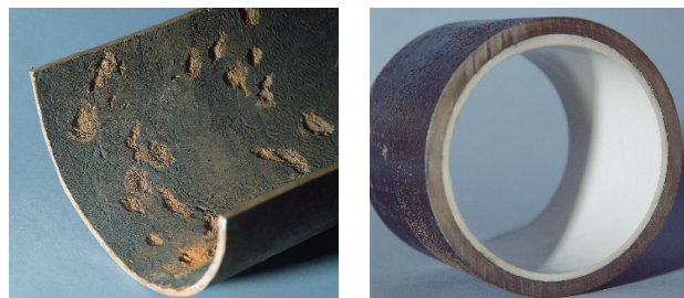
Figur 1: Eksempel på rengjort stål ledning før- og etter renovering med polyuretan.
