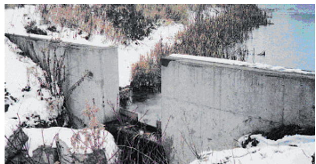
Figur 5: Eksempel på skarpkantet avtrappet utløpsterskel.
