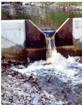
Figur 6: V-overløp kombinert med horisotale overløp.
