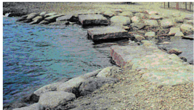
Figur 4: Eksempel på bred horisontal utløpsterskel.
