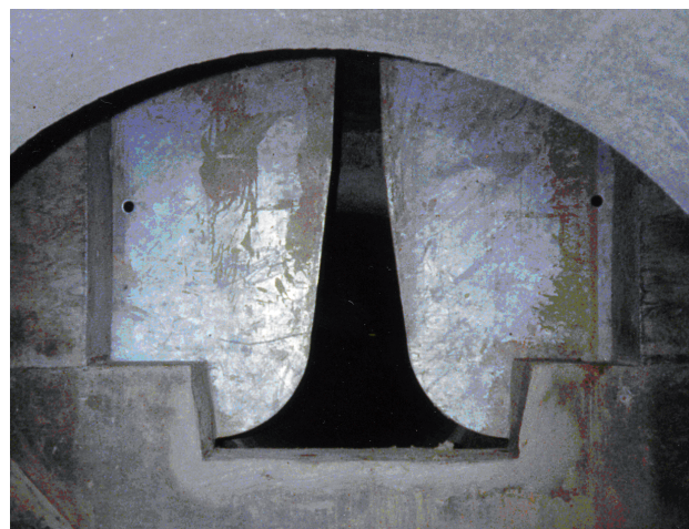
Figur 13: Proporsjonalt overløp.
