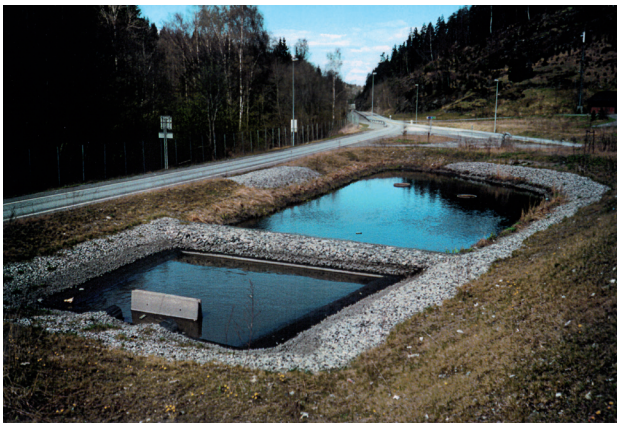
Figur 2: Todelt overvannsdam med energidreper av betong.
