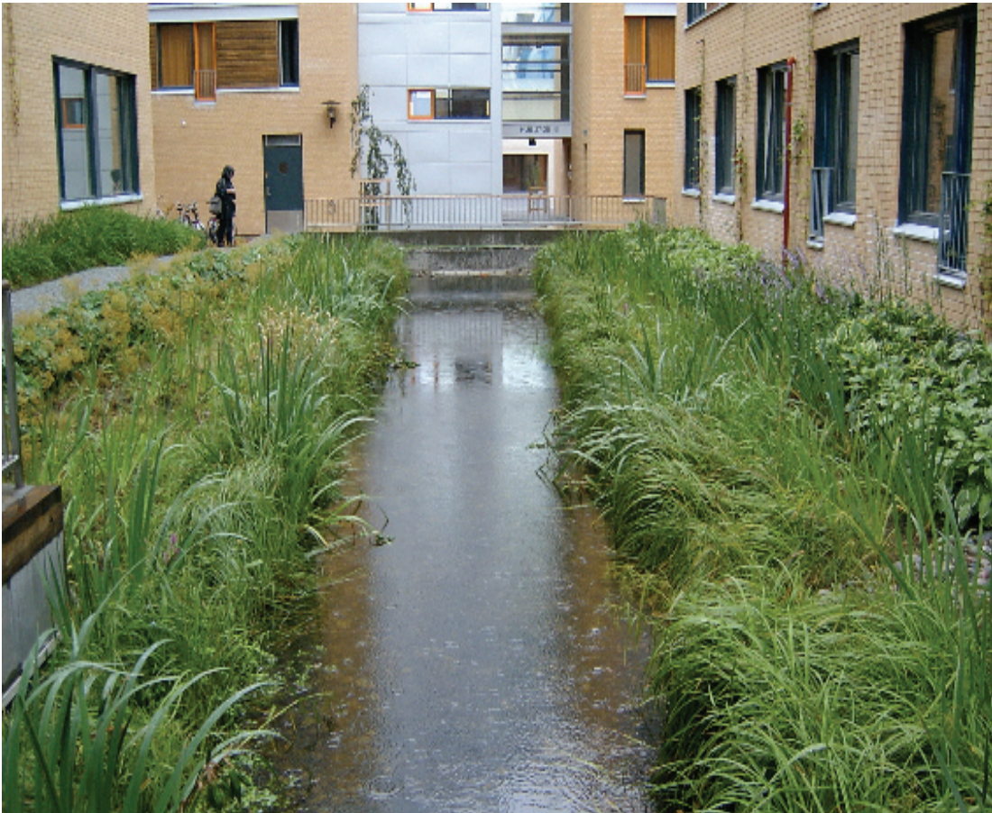
Figur 5. Dam med fast vannspeil i tett bebyggelse for fordrøyning og opplevelse (Bjølser, Oslo kommune).
