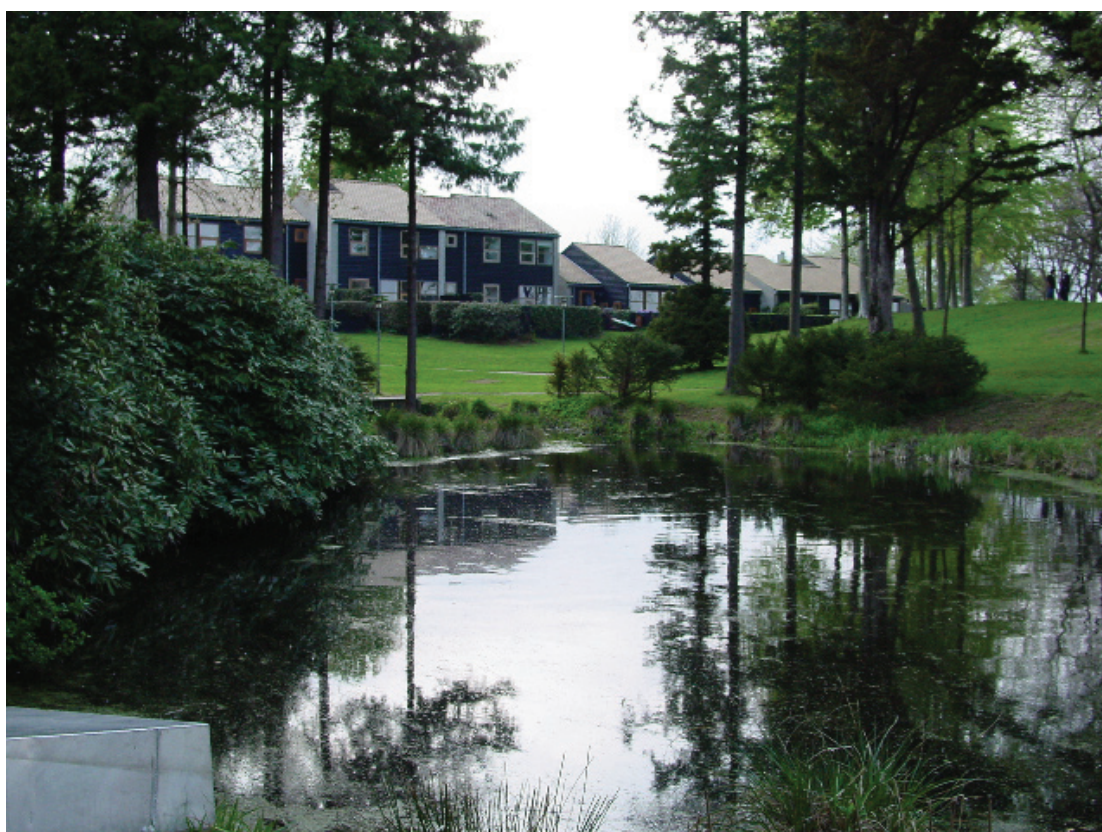
Figur 4. Et vått overvannsbasseng innpasset i et boligområde som kombinerer fordrøyning, økologi og landskapselement (Sjølund, København) (Foto: svein Ole Åstebøl).
