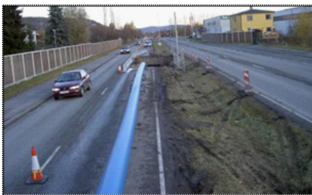
Figur 4: Innføring av nytt rør i eksisterende ledning.
