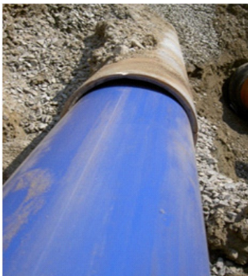
Figur 8: Prinsipp for sammenfoldet rør fra fabrikk ved tilbakeføring til opprinnelig diameter.
