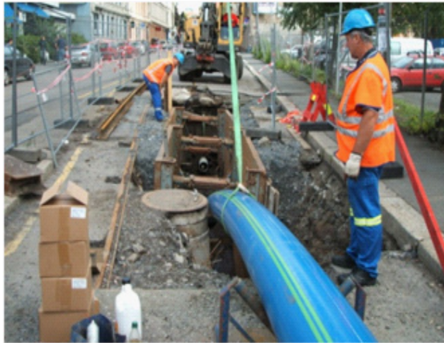
Figur 5: Prinsipp for utblokking av eksisterende rør med innføring av nytt rør.
