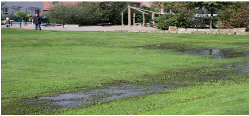
Nedsenket nedsivningsareal etter nedbør.
