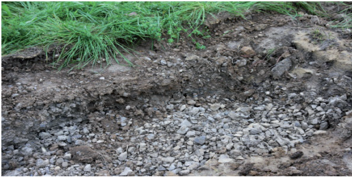
Grus-/stenlag som øker nedsivning i gressareal.
