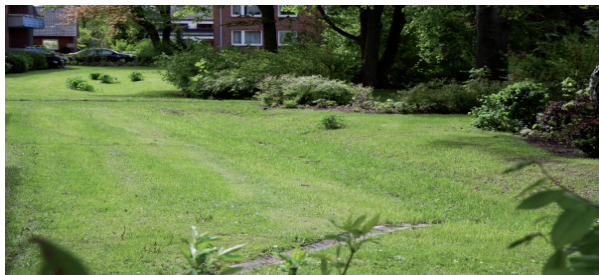
Nedsenket nedsivningsareal mellom små boligblokker.
