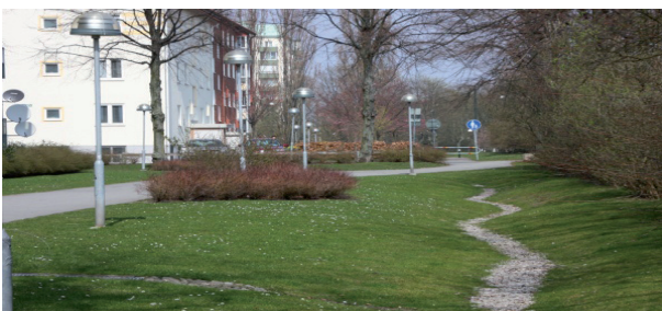
Eksempel på et regnbed ved enebolig og en renne ved en liten boligblokk.
