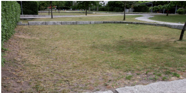
Nedsivningsareal hvor gjerdet av granitt sikrer fordeling av vannet.
