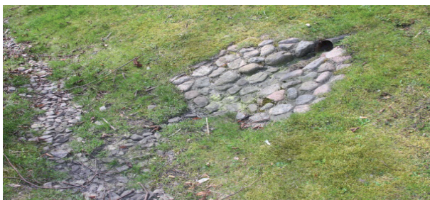
Eksempel på tilløp til en renne utført av natursten lagt i betong.
