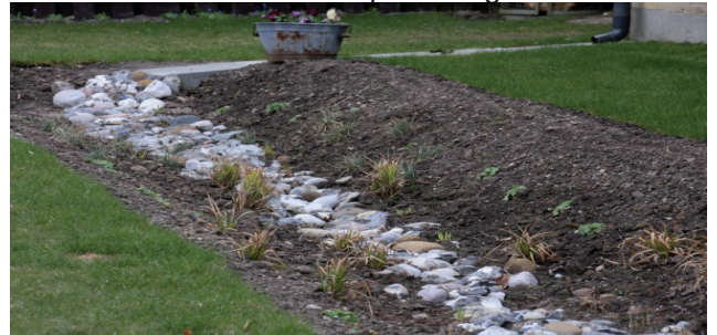
Eksempel på oppbygging av regnbed med tilløp, fordypning med sten og beplantning.
