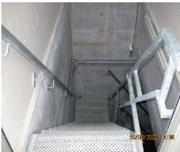
Trapp til basseng via trappehus. Sklisikre trinn og rekkverk på trappen (foto: VandCenter Syd)
