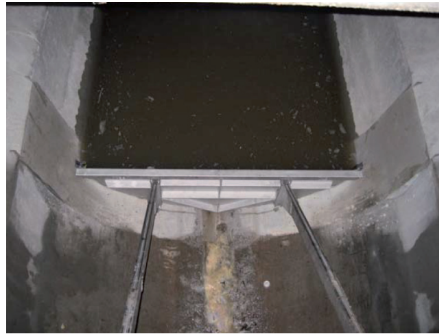
Skylleklapp i rørbasseng (foto: Erling Holm)
