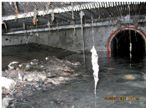
Eksempel på en ikke selvrensende rist i innløp til basseng (foto: VandCenter Syd)
