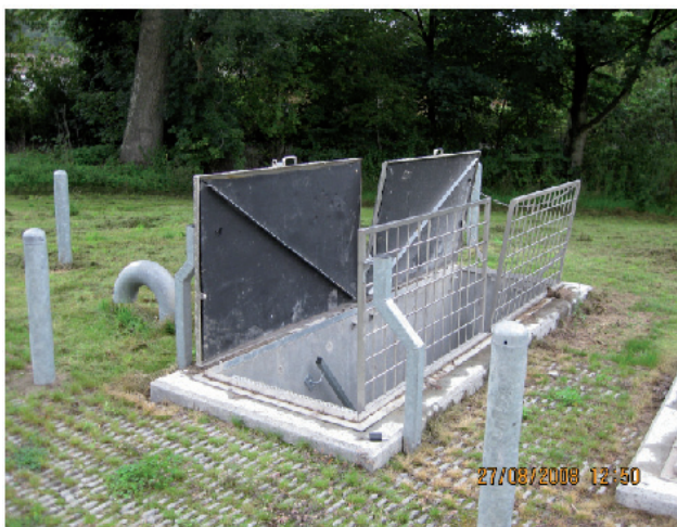
Åpen adgang til trapp (foto: VandCenter Syd)
