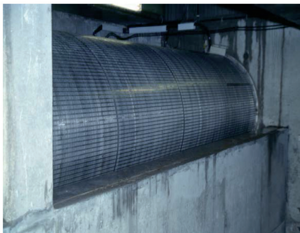
Tromlesil ved avløp fra basseng til resipient (foto: Erling Holm)
