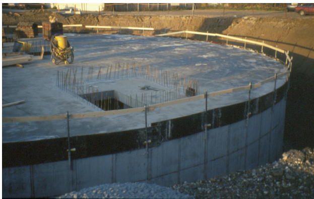
Sirkulært basseng under bygging (foto: Erling Holm)
