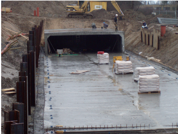
Rektangulært basseng (uten renne) under bygging med elementer (foto: Arkil)
