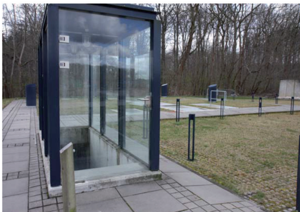
Inngang til basseng via overbygning. Kjøreareal med græsarmeringssten, og areal med øvrige bassengadganger avskjermet av lysstendere. Utluftninger i bakgrunnen (foto: Erling Holm)
