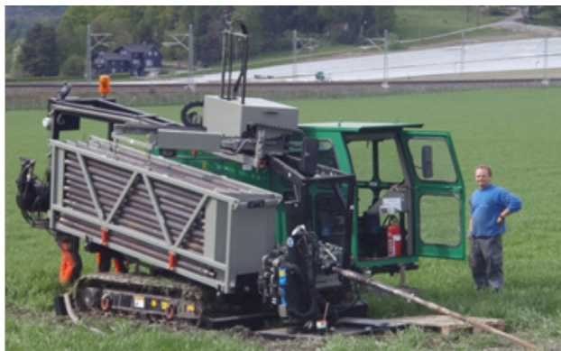
Bilde 2. Rigg for retningsstyrt horisontalboring i løsmasser.
