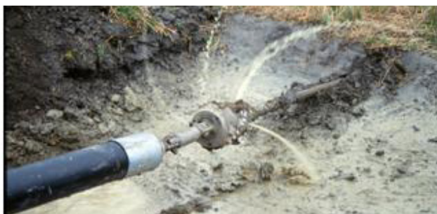
Bilde 4. Rømmekrone med spyling av borevæske ved starten av inntrekking av nytt rør.
