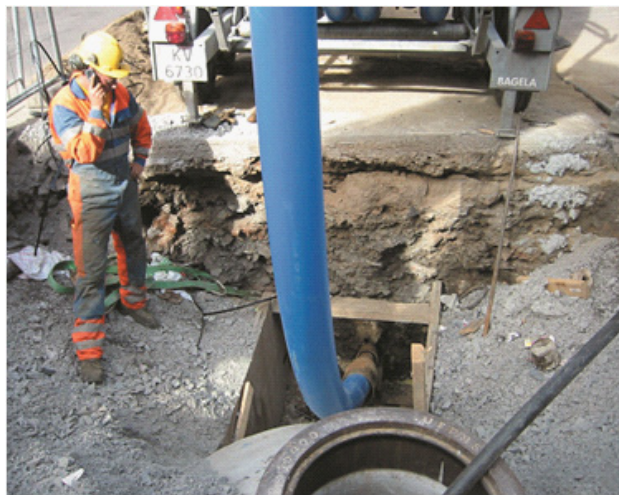
Bilde 1: Installasjon av 180 PE på kveil. Betydelig redusert omfang av gravearbeider, gjør installasjonen spesielt godt egnet i sentrumsområder.
