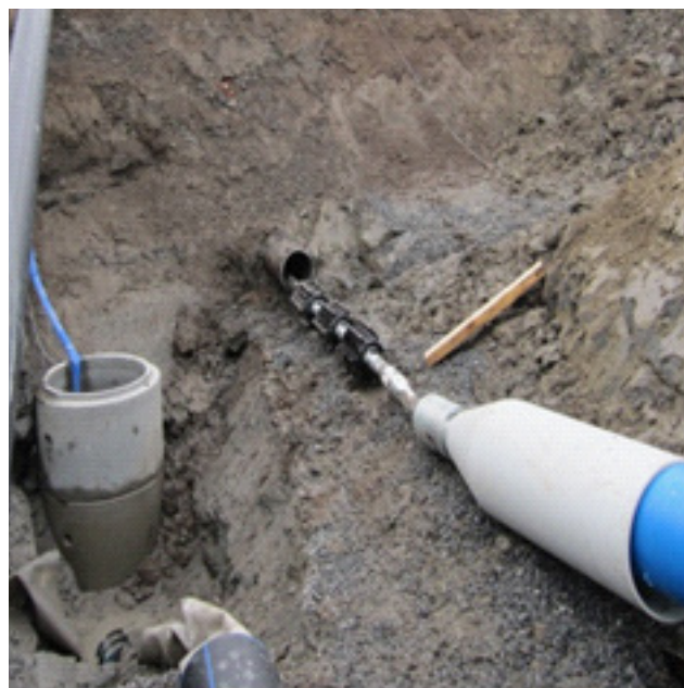
Bilde 4: Nytt medierør klargjort for utblokking med trekkenippel, skjæreutstyr og ekspander.
