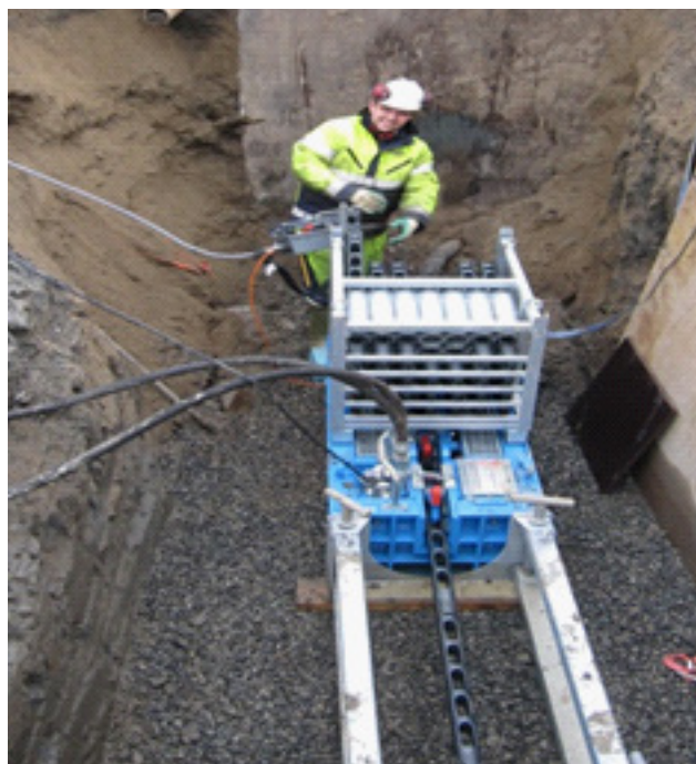
Bilde 2: 80 tonns trekkerigg i mottaksgrop. Typisk rigg for installasjoner i dimensjonsområdet 90 - 315 mm. Trekkestag demonteres etter hvert som installasjonen gjennomføres.
