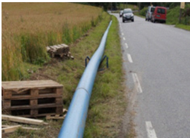
Bilde 5: PE-rør med beskyttelseskappe, ferdig sveiset og lagt opp på ruller, klar til installasjon.
