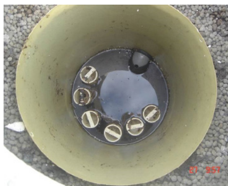
Figur 3. Fordelingskum med justerbare V-overløp. Foto: NIBIO.
