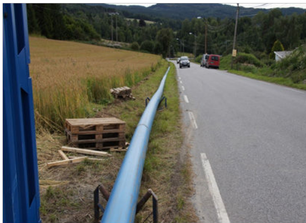
Bilde 1. PE-rør med beskyttelseskappe, ferdig sveiset og lagt opp på ruller, klar til installasjon.
