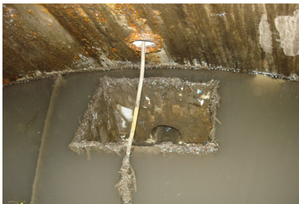
Figur 3. Utløpskasse uten lokk. Rør til avløp sees nede i utløpskassen. Hvis utskilleren oversvømmes, vil oppsamlet olje lekke over kanten og gå urensset til avløp.
