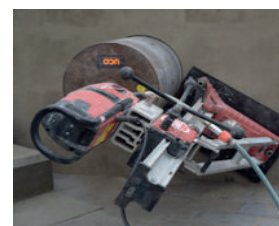
Figur 2. Kjerneboring i felten
