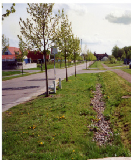
Figur 12 Åpen fordrøynings- og infiltrasjonsgrøft i boligområde
