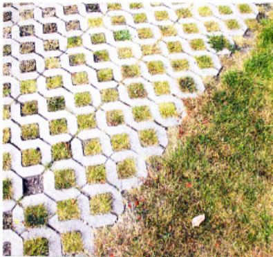
Figur 13 Eksempel på hullsteinsdekke på privat grunn /19/
