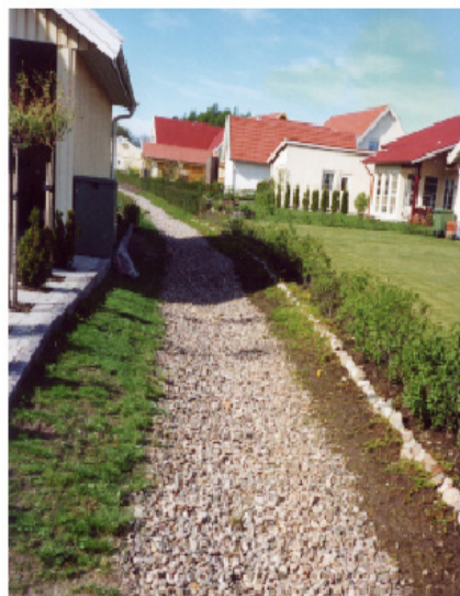
Figur 11 Steinfylt infiltrasjonsgrøft i boligområde
